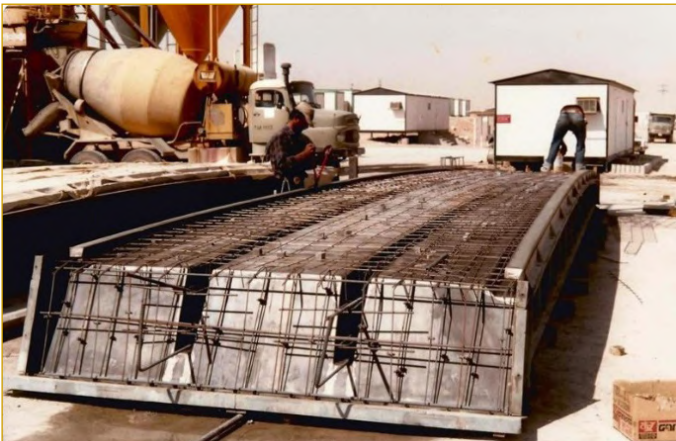
Şekil III.1.19. Küresel kubbe ön üretimli eleman kalıbı Tip1
