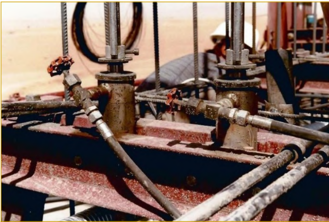
Şekil III.1.11. Kayar kalıp hidrolik tırmanma detayı
