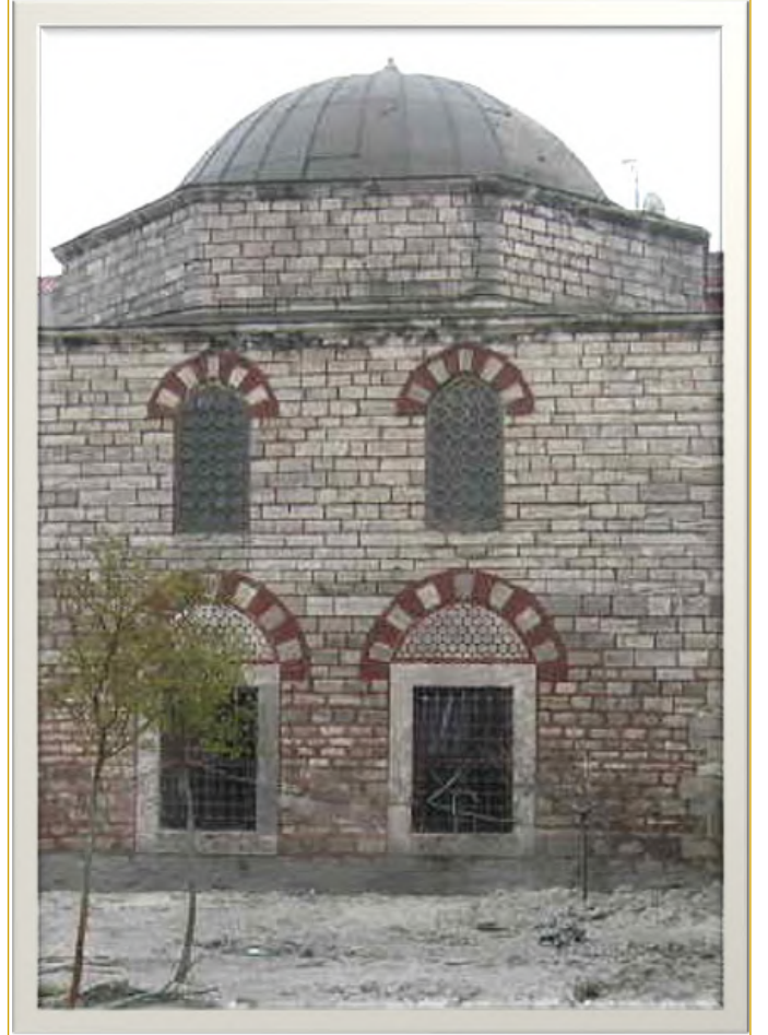
Şekil IX.5. Küresel kubbe, dairesel plak, kompozit çember kirişi gibi eleman türlerinin yapı üzerinde konumlandırıldıkları bir örnek
