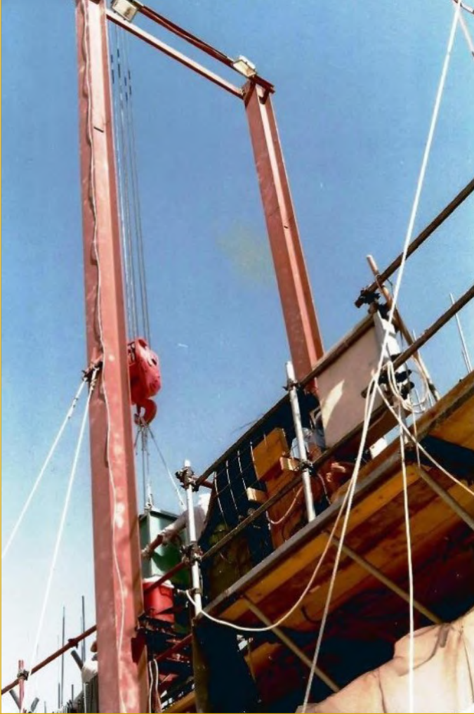
Şekil III.1.7. Tırmanan kalıp (kayar kalıp)
