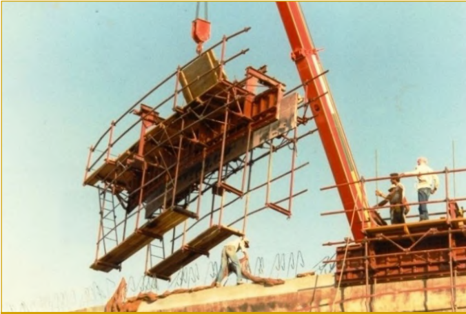
Şekil III.1.16. Kayar kalıp sökülmesi
