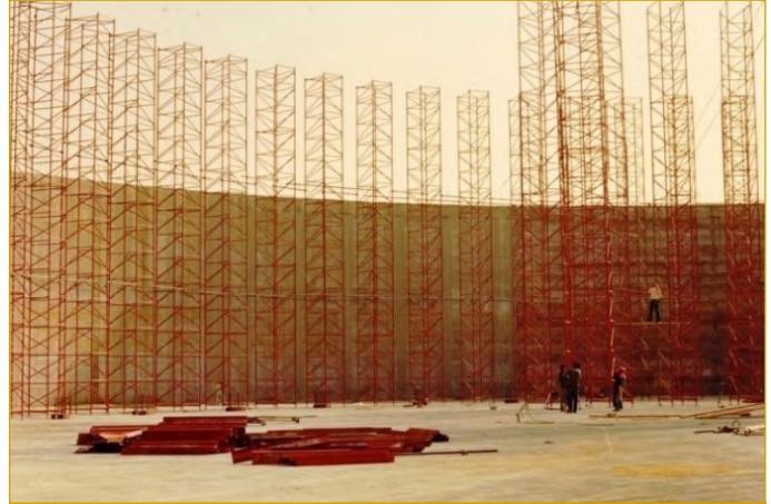
Şekil III.1.20 Küresel kubbe için geçici iskele
