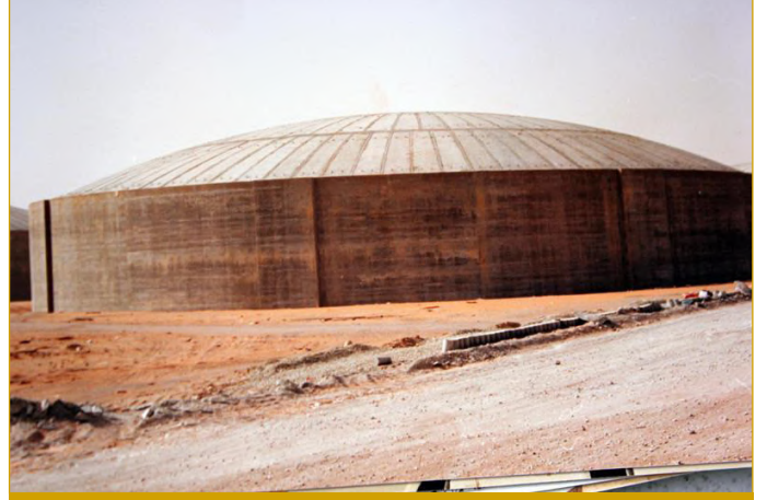
Şekil III.1.26. Betonarme inşaatı tamamlanmış depolar
