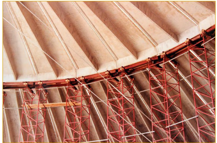
Şekil III.1.22. Küresel kubbe montajı
