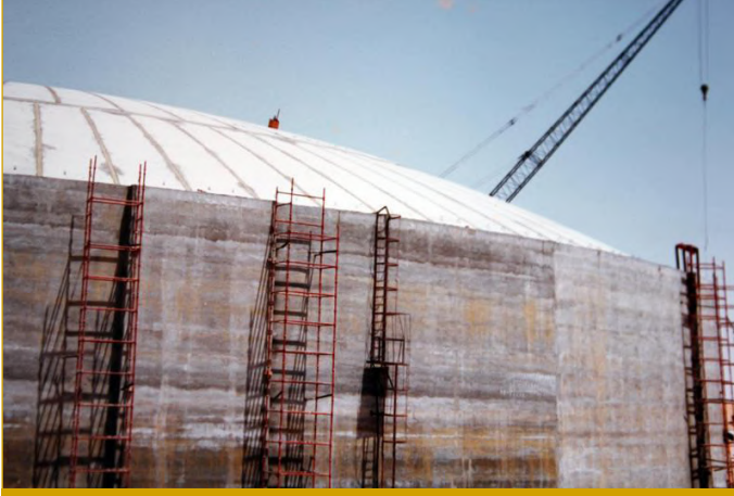
Şekil III.1.23. Kubbe bağlantılarının tamamlanması
