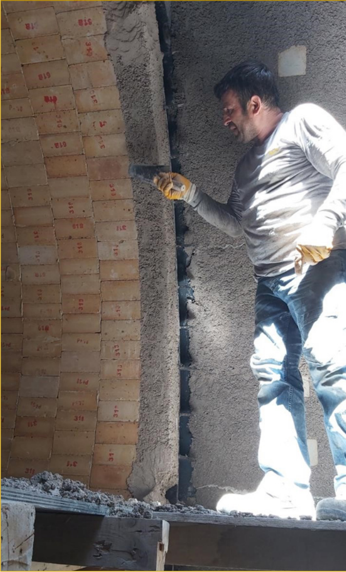
Şekil 4.12. Plastik Dövme Uygulamasında Tıraşlama İşlemi 77
