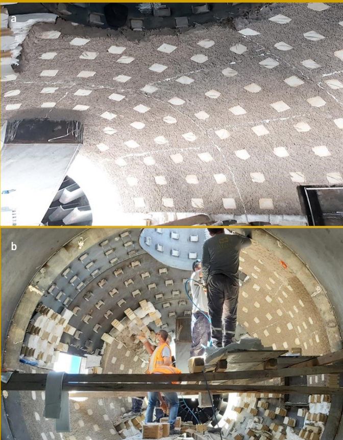
Şekil 4.11a-b. Tavan Yapılarında Plastik Dövme Uygulamasına Örnekler 77
