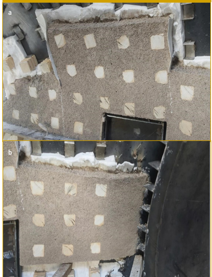
Şekil 4.9a-b. Yan Duvarların Plastik (Dövme) Uygulamaları 77
