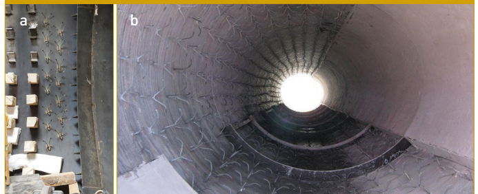
Şekil 4.15a-b. Çeşitli Çelik Kancalar ve Bağ Tuğlaları Kullanılarak Uygulanan Ankraj Örnekleri 77
