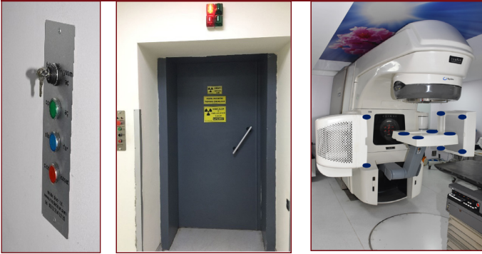
Şekil 2. Linac cihazı kapı ve çarpışma kilitleri
